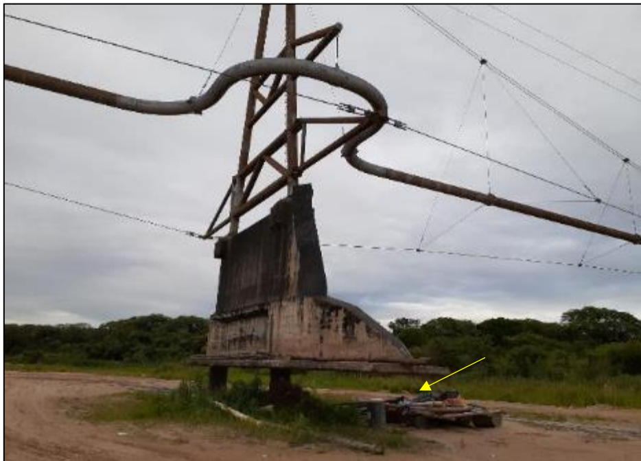
Foto 3. Socavación de base torre debajo de la zapata utilizan como campamento personal de la zona que trabajan en la extracción de áridos.
