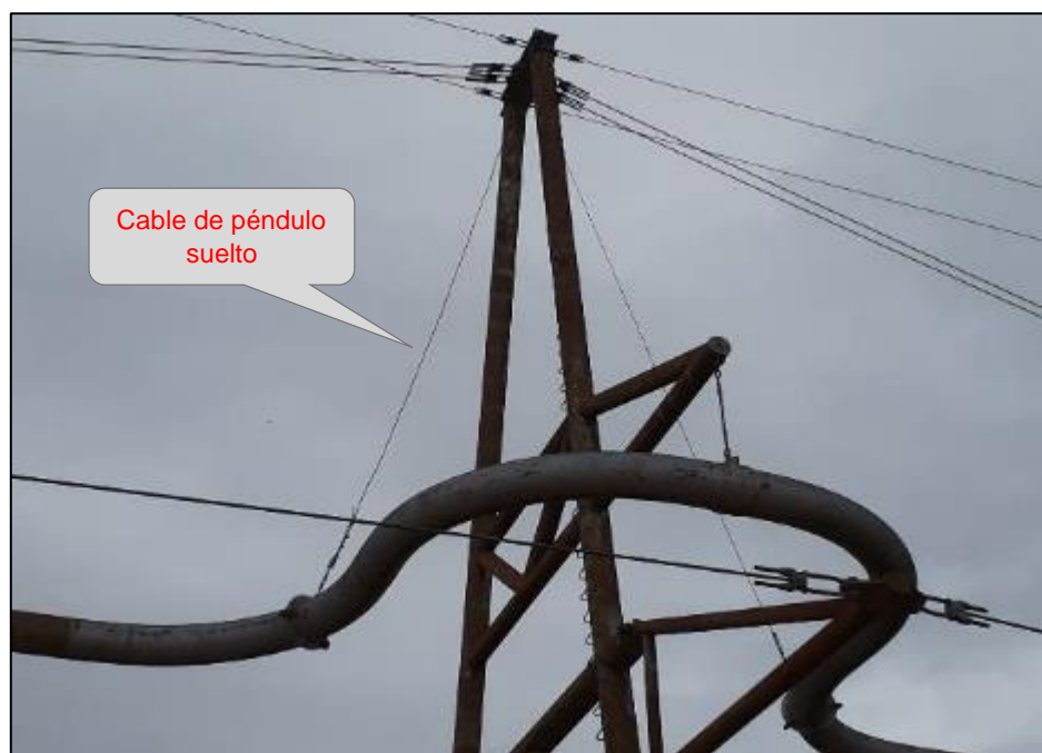
Foto 4. En esta torre el cable del pendulon esta suelto
