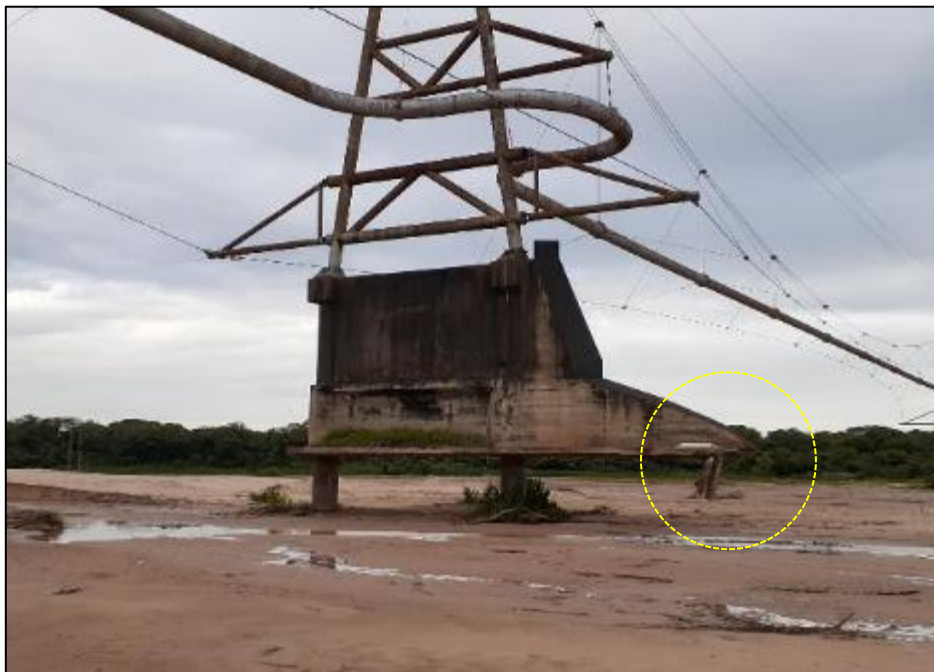
Foto 3. Base de zapatas deteriorados por corrosión de la enferradura
