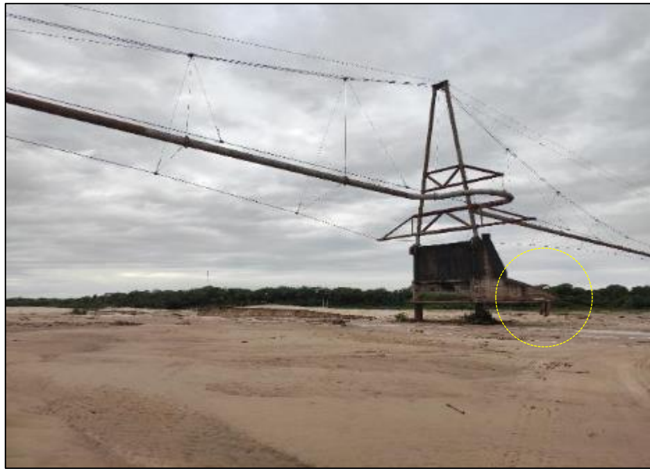
Foto 6. Base de zapata de la torre esta con rajaduras cayendose por deterioro del acero del hormigon
