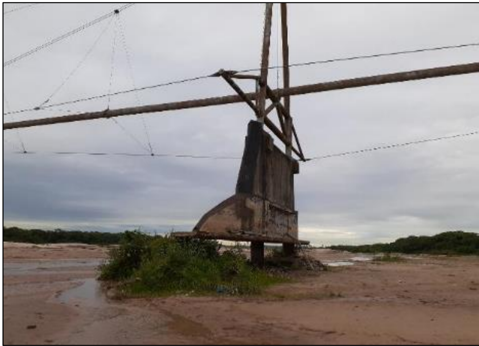
Foto 2. Se observan daños en la base de la zapata de homigon de la torre
