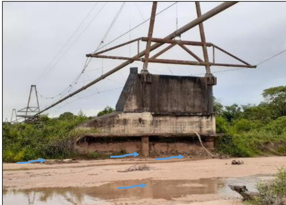
Foto 1. Muestra la erosión lateral causado por el rio lado noreste.
