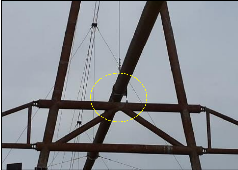
Foto 2. Grampa liberada para evitar estrés por dilatación
