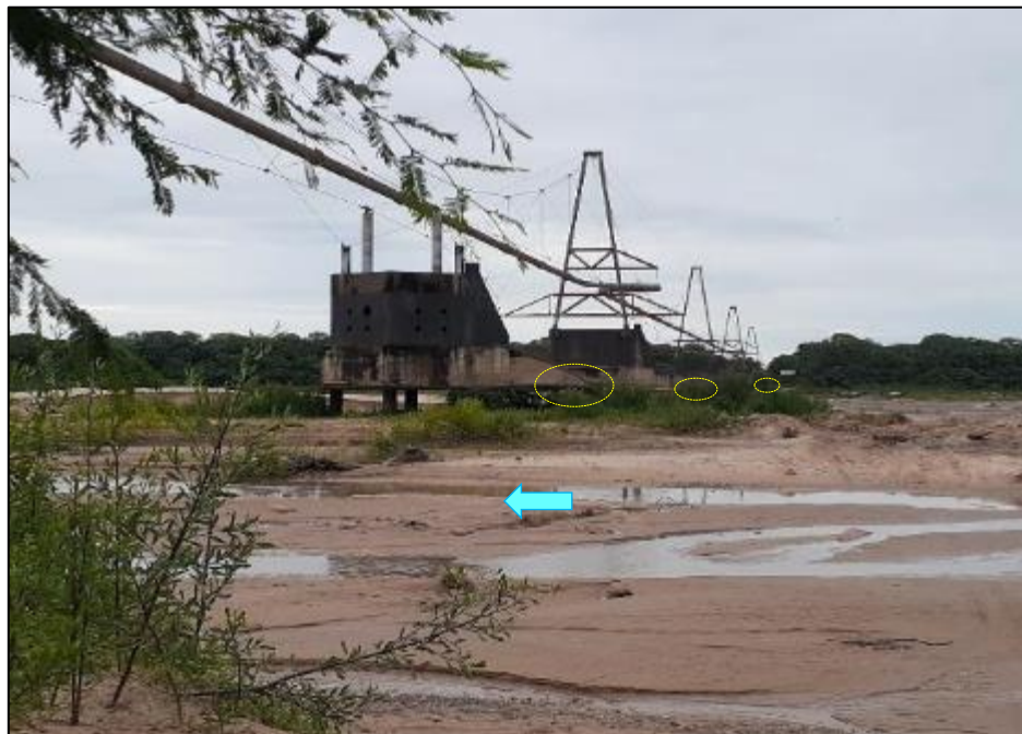
Foto 7. Vista desde antes del cruce direccion del flujo y socavacion de las bases
