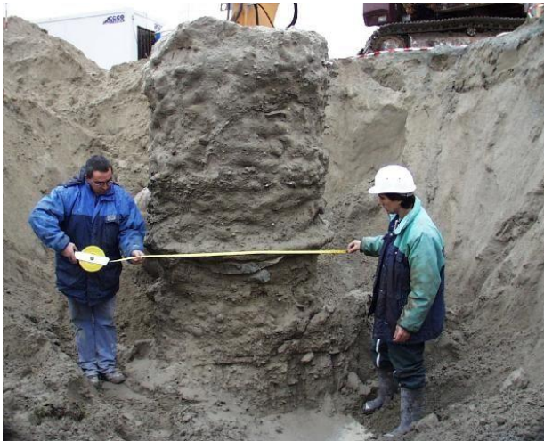
Foto 13. Se observa refuerzo del subsuelo con jet grout luego de fraguado. Diámetro de casi 1.10m (PROPUESTA 2)
