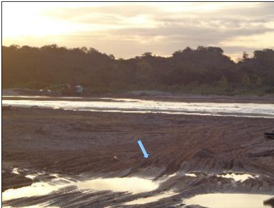
Foto 10. Explotacion de aridos en toda la rivera de la cuenca de este sector produciendo degradación del lecho que afecta la estabilidad de las pilas del puente
