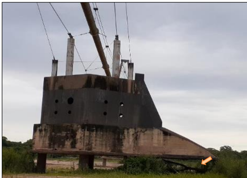
Foto 5. Se muestra corrosion en las bases de la torre al igual que en la anterior debajo de la zapata esta siendo utilizado como campamento por el personal que extrae los aridos de este sitio
